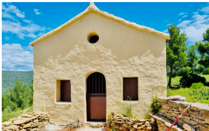
Rafraichissement de la Chapelle Sainte Croix
