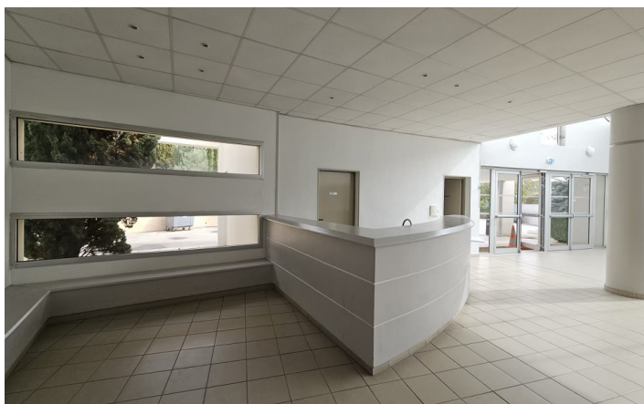
Travaux de rénovation de la Salle Polyvalente
